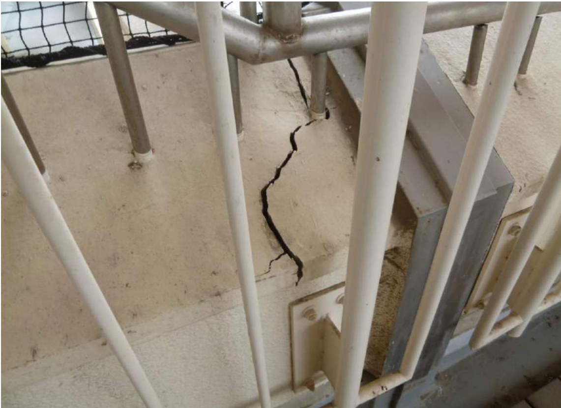
↑ 西側「渡り廊下屋上(西側)
