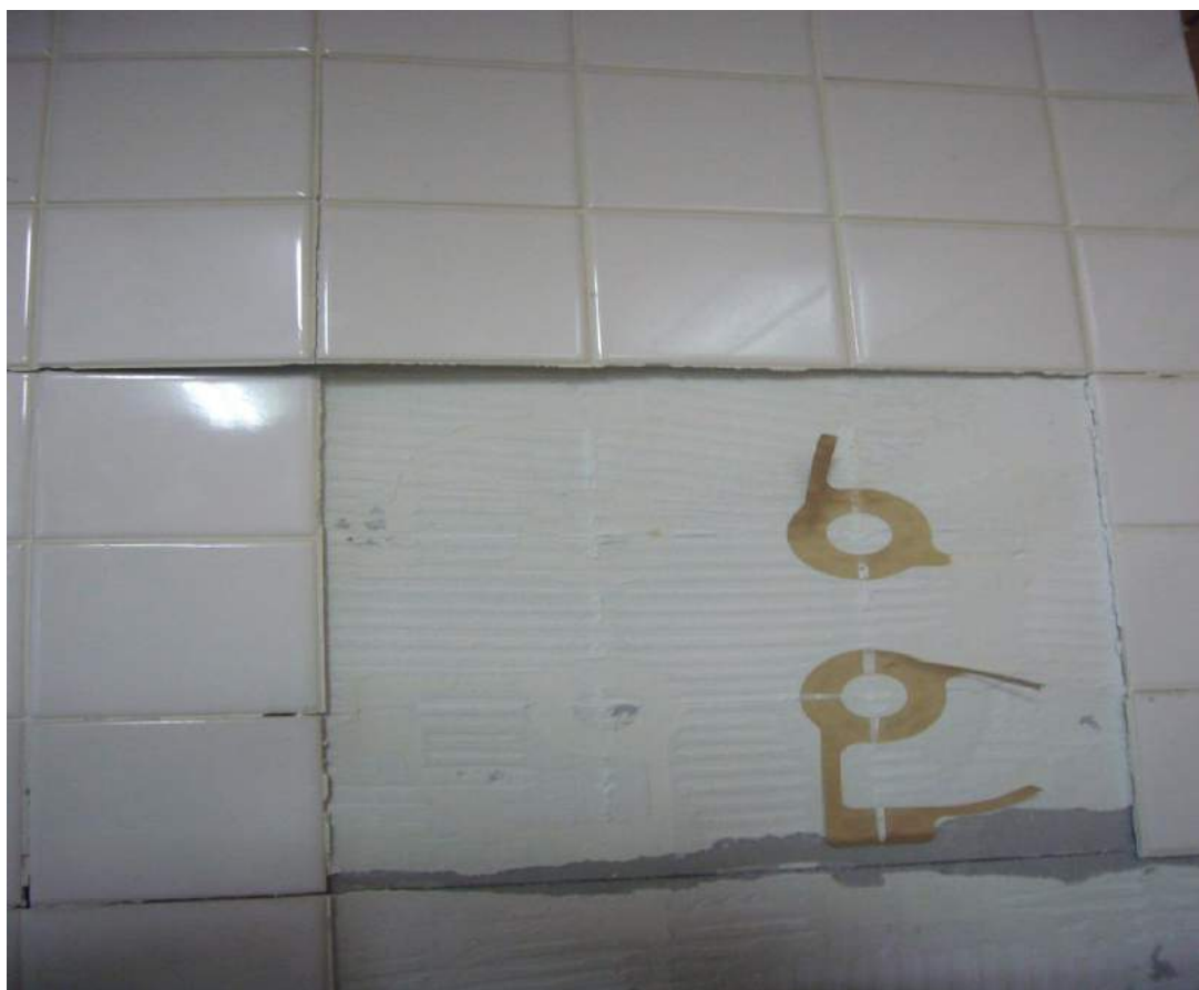
保健室、手洗いのタイル
