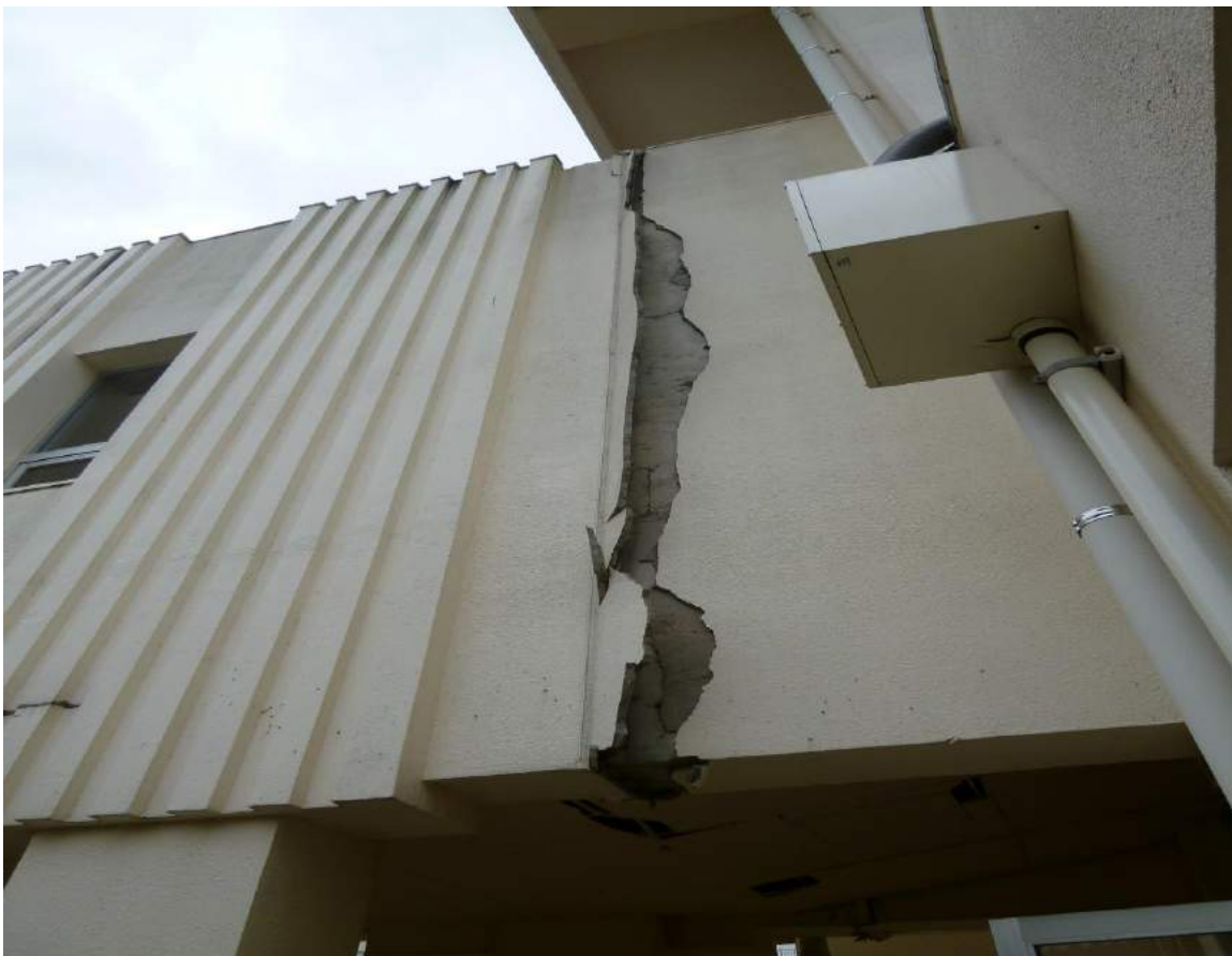
↑ 東側渡り廊下 つなぎ目
