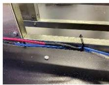
写真8 断線個所の取替
